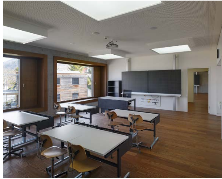
Ein Klassenzimmer des Heilpädagogischen Zentrums, Schaan. Erstellt 2014, Lichtkonzept nach Grundsätzen HCL mit grossen, flächigen, dynamisch steuerbaren Leuchten an der Decke. (Bild: Marc Lins, Fotograf)
