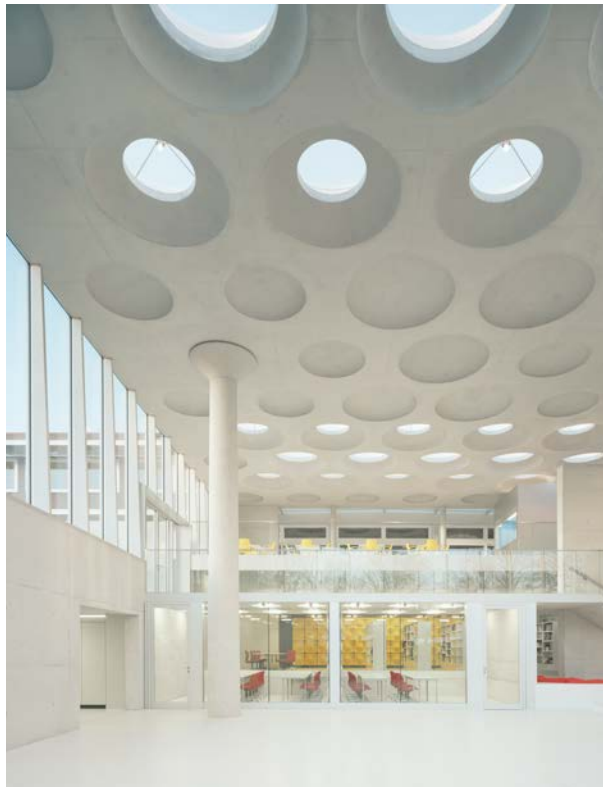
Forum am Eckenberg Gymnasium, Adelsheim. Gebäude mit grosser Tageslichtnutzung und darauf abgestimmtes Kunstlicht. Tageslichteintrag von mehreren Seiten, helle Oberflächen, flexibles Sonnenschutzsystem, in die Architektur integrierte Leuchten für Funktionslicht, Raumlicht und Akzentuierung. (Bild: Brigida Gonzales, Fotografin)
